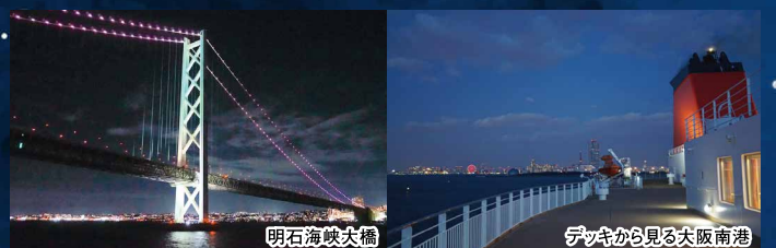
明石海峡大橋
